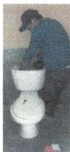
Foto 5: Mantenimiento de accesorios de sanitario.
