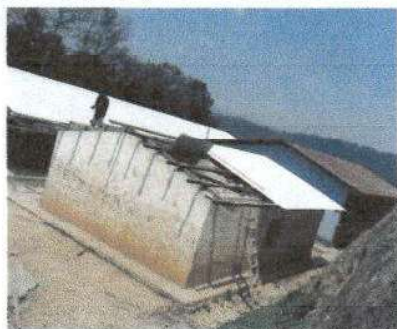
Foto 1: Instalacion de lamina troquelada calibre 26.
