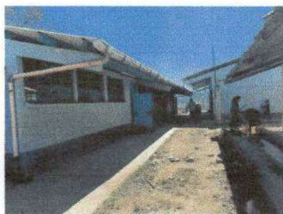
Foto 3: Preparacion de torta de piso de la escuela.
