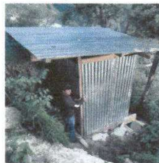
Foto 4: Instalacion del inodoro de fosa septica.
