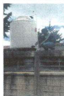
Foto 2: Instalacion de deposito de agua de 1,100 litros.
