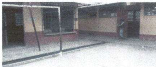
Foto 6: Cambio de chapa nueva para puertas.
